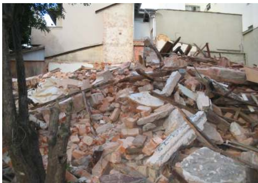
Casarão em processo de tombamento foi demolido
